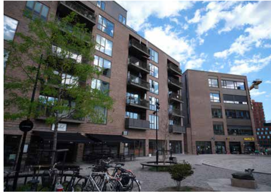
BYGGEFELT 11.1 Emil Christian Hansens Hus Entreprenør Arpe & Kjeldsholm A/S Ingeniør Rambøll A/S Arkitekt Danielsen Architecture A/S DGNB Guld
