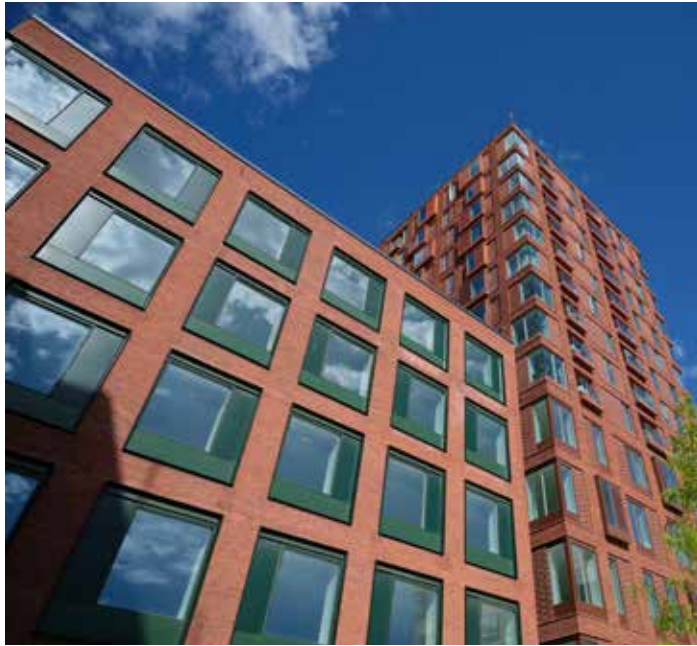
BYGGEFELT 10.3 Wingehus og Grønlunds Tårn Entreprenør Arpe & Kjeldsholm A/S Ingeniør Niras A/S Arkitekt C.F. Møller Architects A/S
