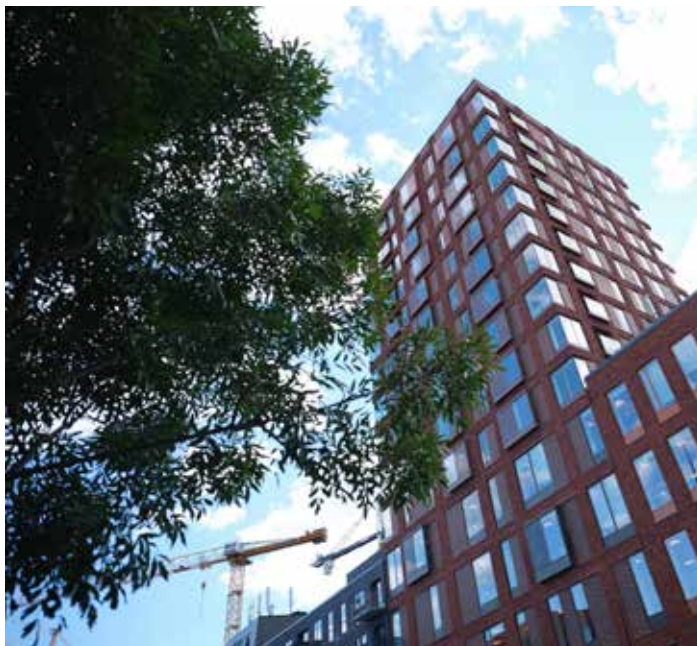
BYGGEFELT 15 Frstrup hus og Tuxen Tårn Entreprenør Arpe & Kjeldsholm A/S Ingeniør Niras A/S Arkitekt C.F. Møller Architects A/S DGNB Guld for erhverv
