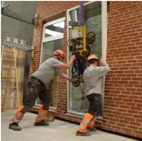
Vinduer, altanbeslag, sølbænke og solafskærmninger er eksempler på løsninger, som kan monteres fra fabrik.
