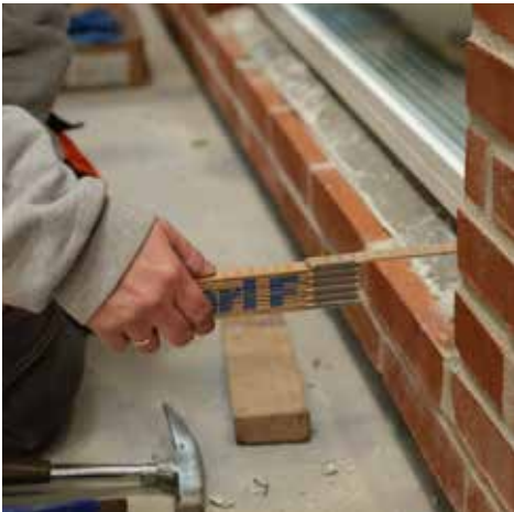
Vinduer kontrolmåles i forbindelse med kvalitetskontrollen.
