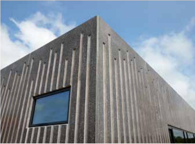
MØNSTRINGSHUS, ESBJERG Polerede grå sandwichfacader med flotte risalitter kræver høj præcision.
