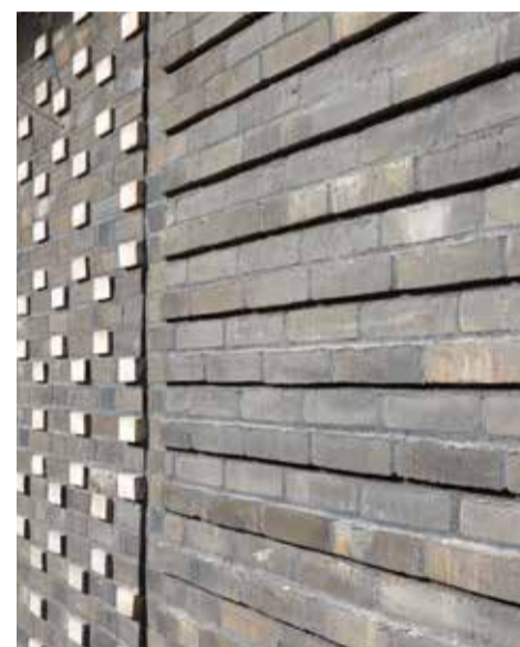
Et særligt udtryk i facaden er opnået ved at bruge gule kopper i den mørke facade.
