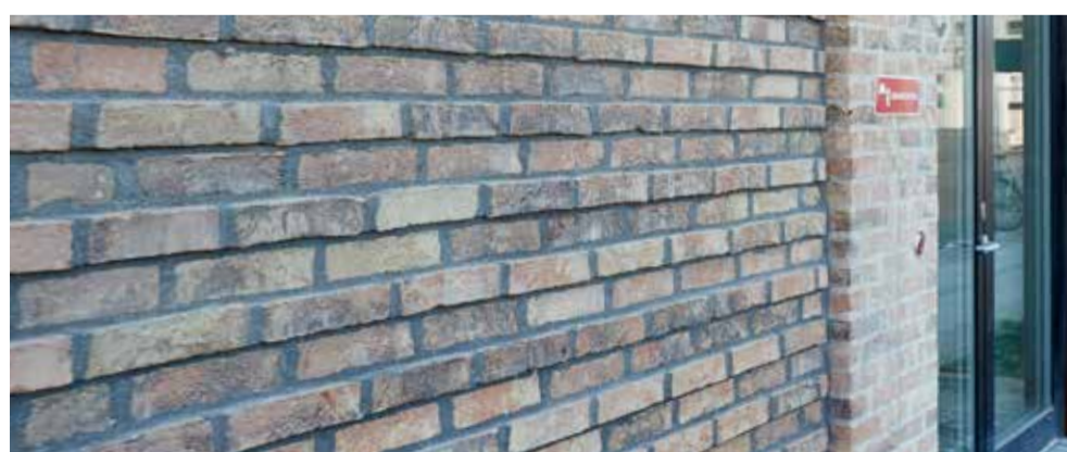
Samme mursten er brugt til facaden – men to forskellige fugefarver giver et flot spil. Samtidig er hver anden mursten forskudt, så der dannes et flot bånd
