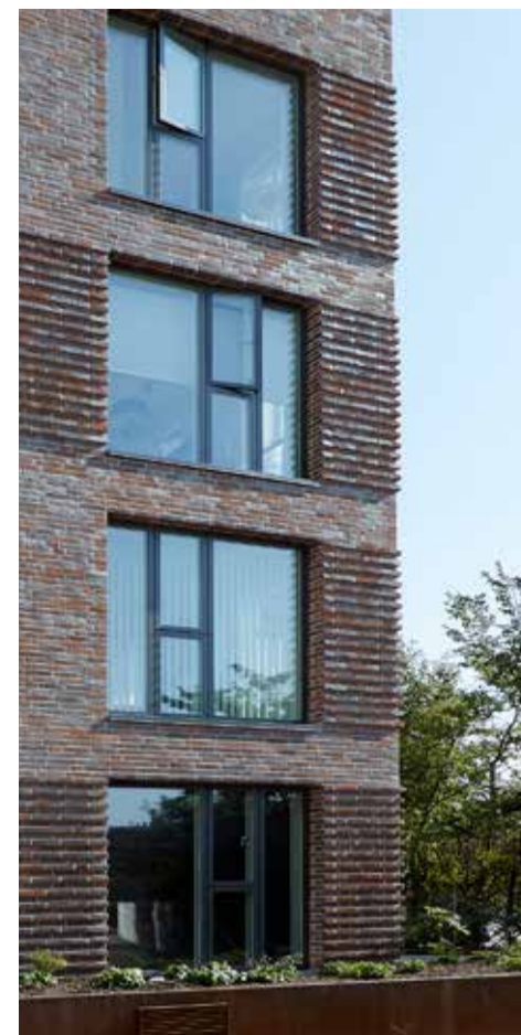
Klassiske og flotte bånd dannet i mursten ved vinduerne.
