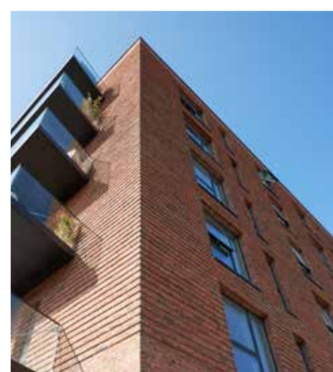
Et unikt mønster i facaden er opnået ved at trække murstenen ud og lave gennemgående bånd.
