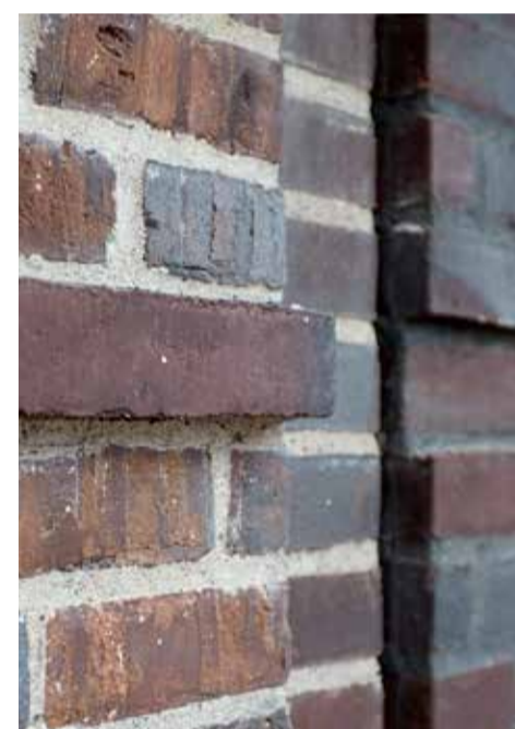
Samme mursten – men opmuret med to forskellige fugefarver. En ekstra detalje er, at murstenen i den grå fuge er vendt "forkert", så den fremstår markant og rå.
