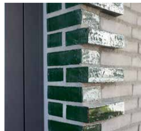
Glaserede mursten brugt som afslutning ved døråbninger.
