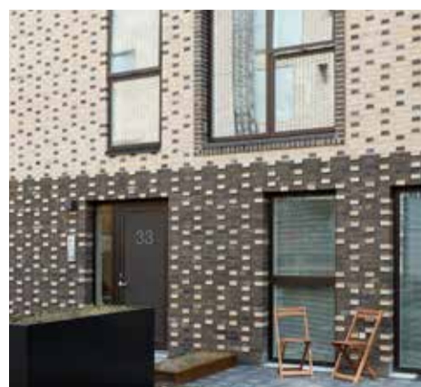
Flot kombinationsmønster med sorte og gule mursten. Både i facaden og rundt om vinduerne er der leget med farverne.
