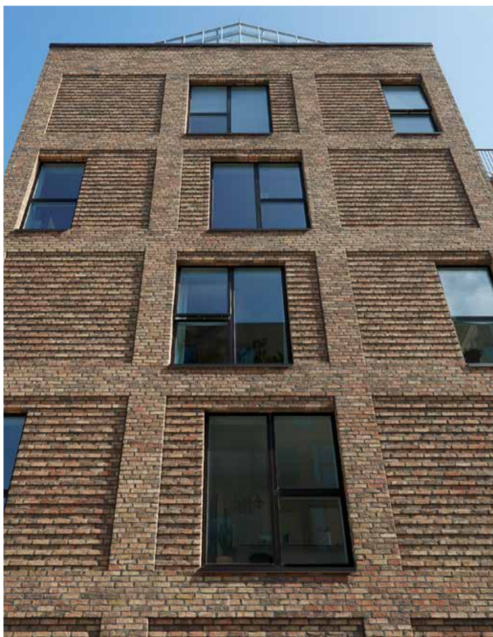
Flot mønster i mursten som giver et udtryk af en rå newyorker fabriksfacade.
