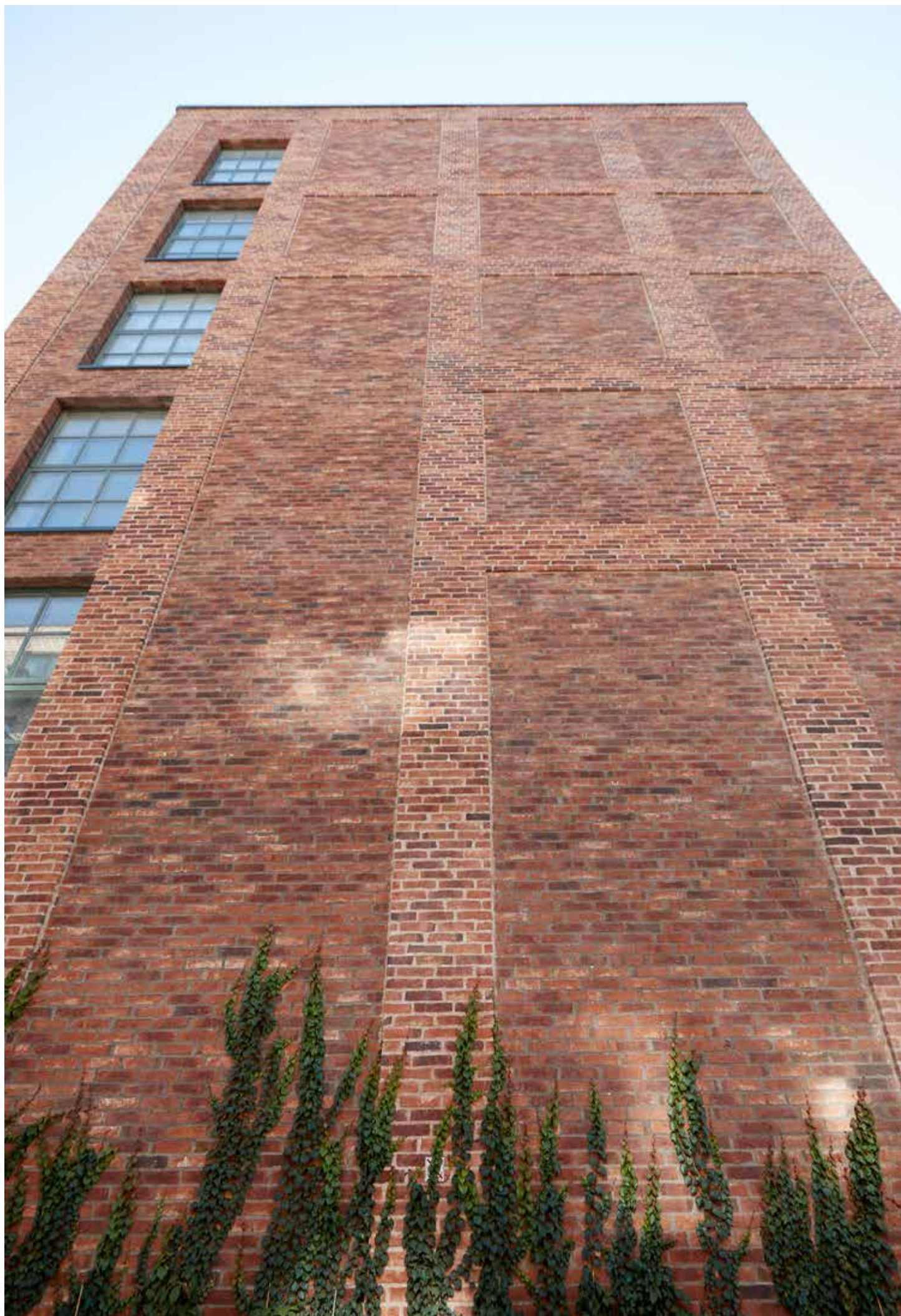
Samme mursten er brugt til opmuring af denne facade. Det er blot fugefarven, som er skiftet fra mørk til lys.
