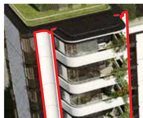
De særlige "næser" på Greenhouse, som er 860 mm. Der er 3 altaner på hver etage og en næse på hver side af altanen.
