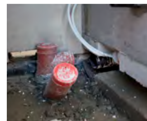
Let og enkel tilslutning af badeværelset ude på byggepladsen.
