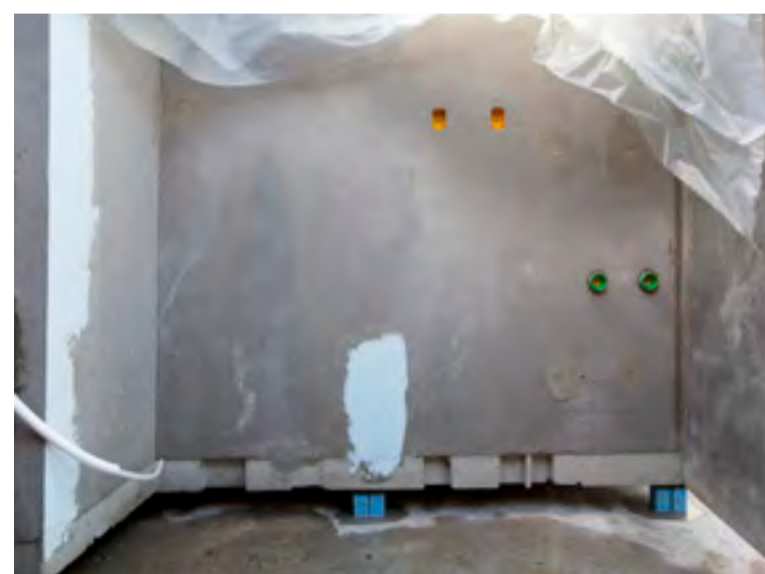
I højre side af badeværelset er væggene til tekøkkenet allerede klar - inkl. rørføring til vand og elinstallationer.
