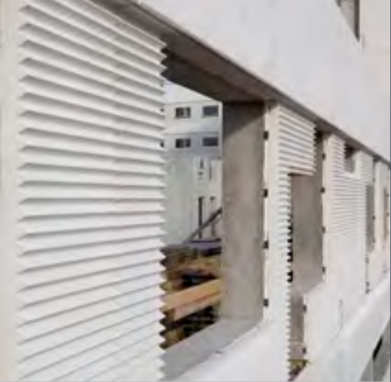
Særlig profilering i sandwichfacaderne.
