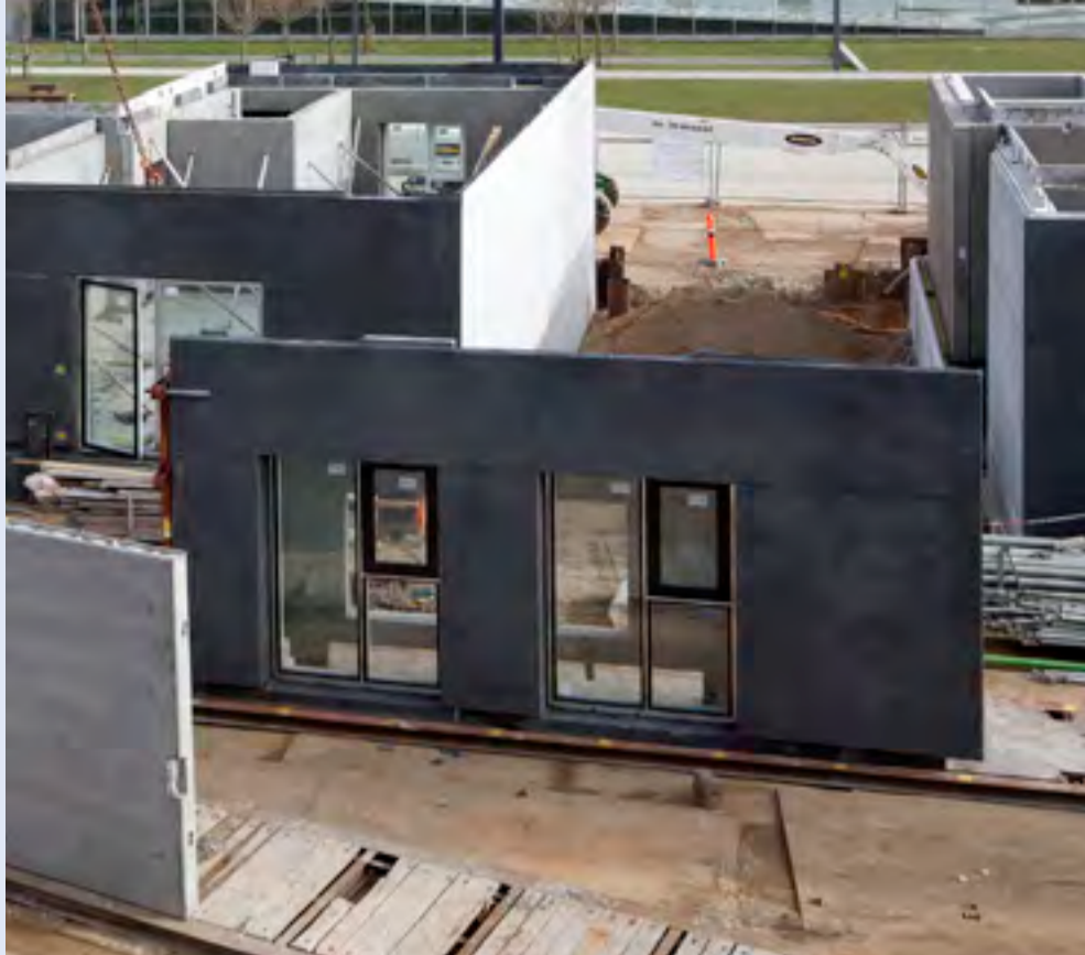
81 boliger i Ørestad Syd - 5 til 11 etager faldende mod udsigten over Fælleden. Facadeelementerne leveres med vinduer monteret fra fabrik.
